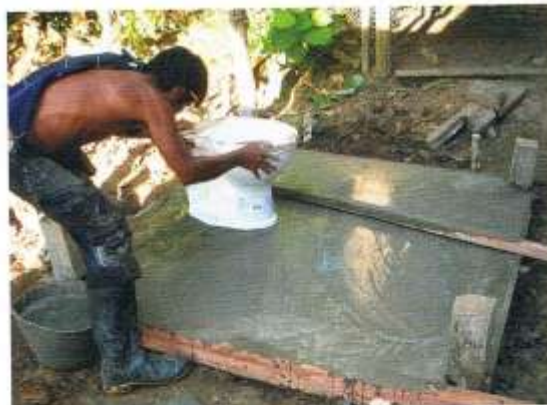
Het installeren van WC- potten vergt precisie.
