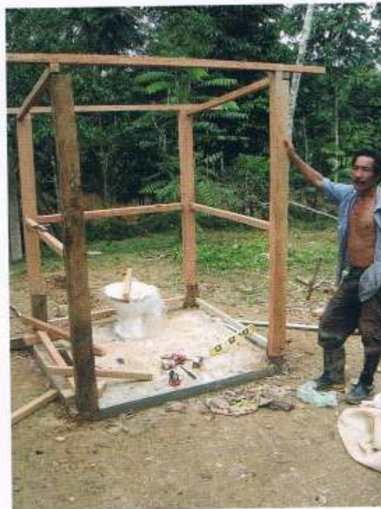
Een trotse installateur toont het resultaat van de wc-pottenacties in Nederland.
