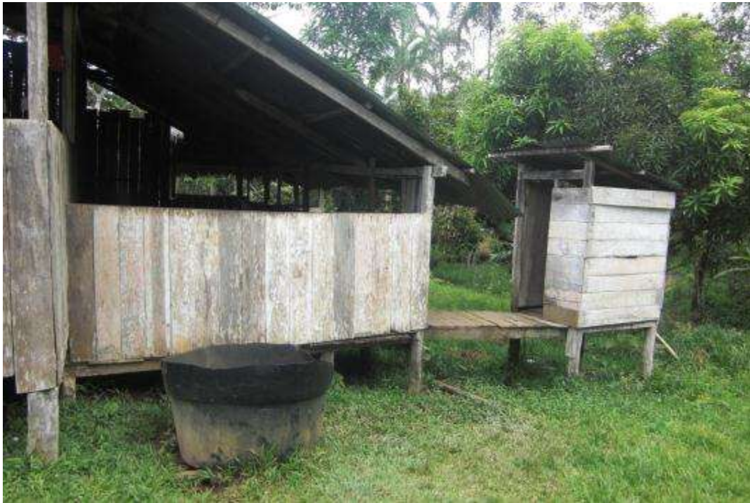
Toilet en watertank van de kleuterschool.
